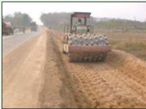
รูปที่ 4-12 การบดอัดงานดินถมคันทาง
