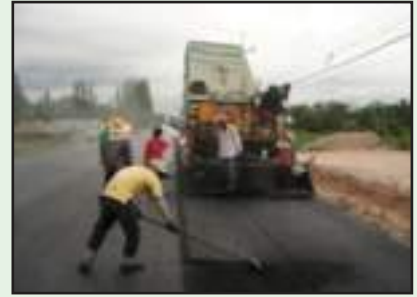
ควบคุมแนวการปู
