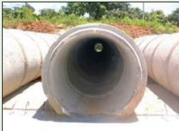
รูปที่ 5-37 การเทคานหน้าท่ออาจทำในขั้นตอนการเทคอนกรีตหยาบร่องท่อก็ได้
