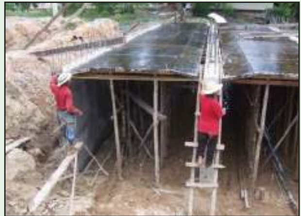
รูปที่ 5-23 การประกอบติดตั้งแบบหล่อ
