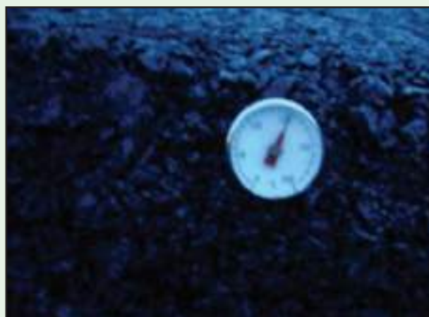
รูปที่ 6-28 ตรวจสอบอุณหภูมิก่อนใช้งานและขณะปูลงบนพื้นทางต้องอยู่ในช่วง 120 - 150^{\circ}\text{C}
