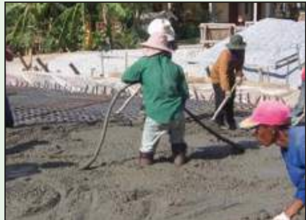
รูปที่ 5-28 (ข) การจี้คอนกรีตขณะเทคอนกรีต
