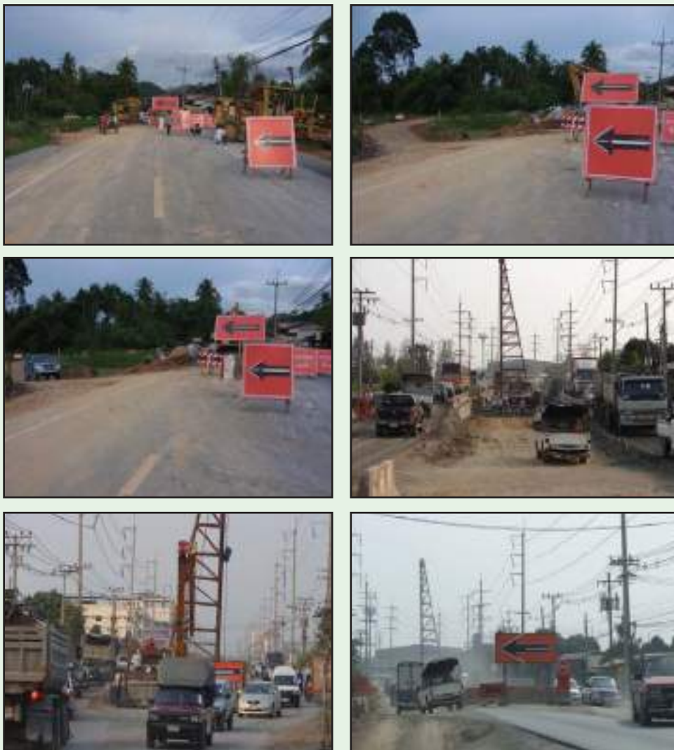
รูปที่ 8-5 การเบี่ยงการจราจร กรณีงานก่อสร้างทางและสะพานเขตชุมชน
