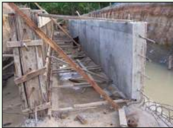
รูปที่ 5-26 เสริมเหล็ก Dowel ให้ตรงตามตำแหน่ง
