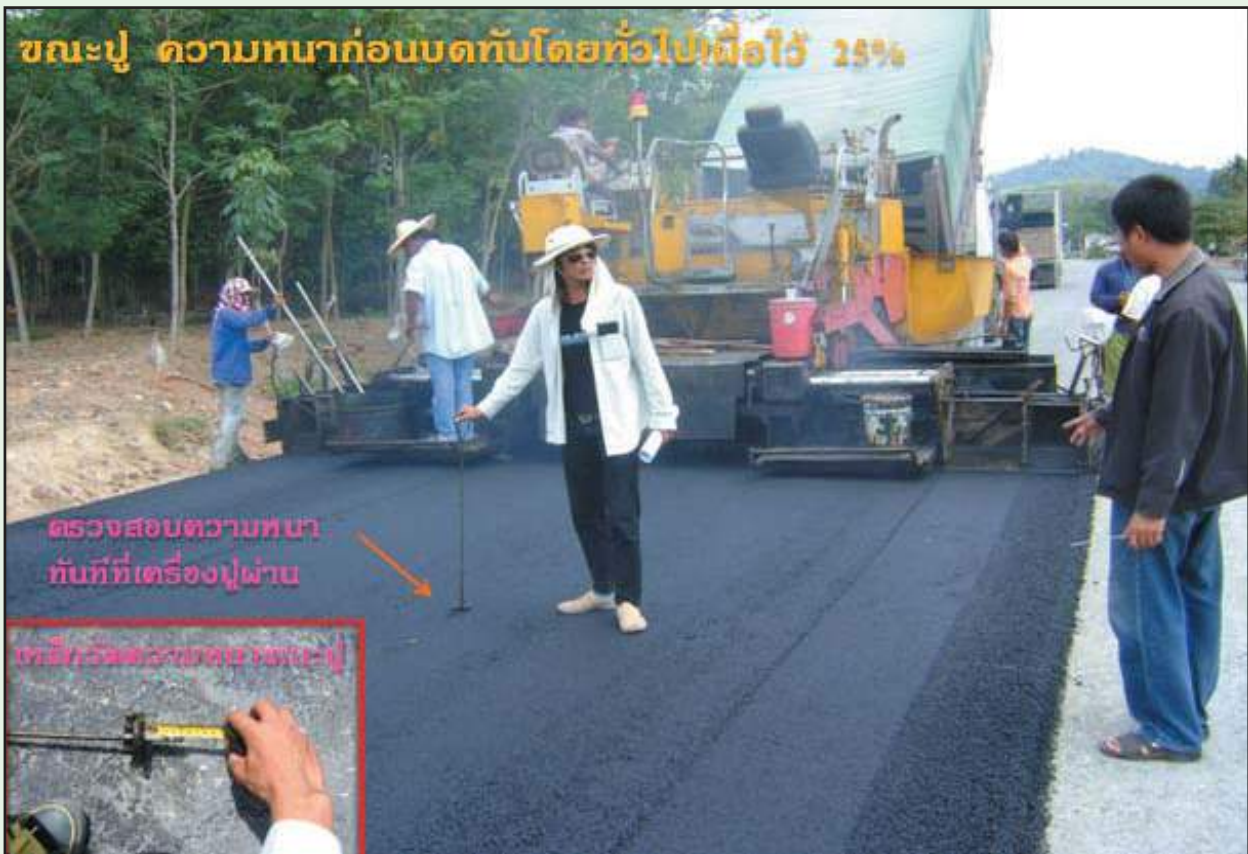
รูปที่ 6-30 แสดงการตรวจสอบความหนาขณะปูแอสฟัลต์คอนกรีต
