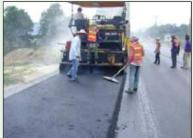
รูปที่ 6-35 การบดทับและแต่งแนวขณะปู
