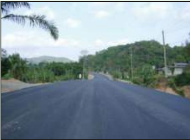
รูปที่ 6-39 ผิวทางที่ก่อสร้างแล้วเสร็จ จะต้องเรียบได้ระดับและรูปแบบ
