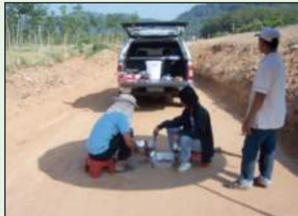
รูปที่ 4-19 ทดสอบความแน่นของงานดินถมแต่ละชั้น
