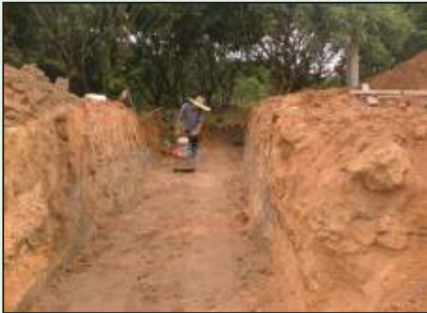
รูปที่ 5-10 การบดอัดดินให้แน่นก่อนเทคอนกรีตหยาบรองรับท่อ
