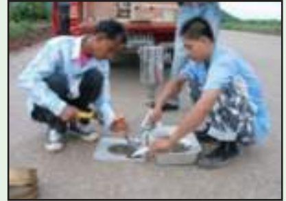
การทดสอบความแน่น
