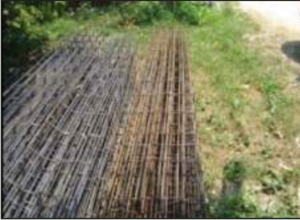
ตรวจสอบการเสริมเหล็ก
