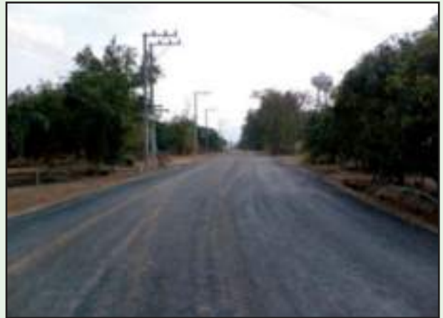
รูปที่ 6-8 ลักษณะผิวทางหลังการลาดยางรองพื้นแอสฟัลต์ (Prime Coat)
