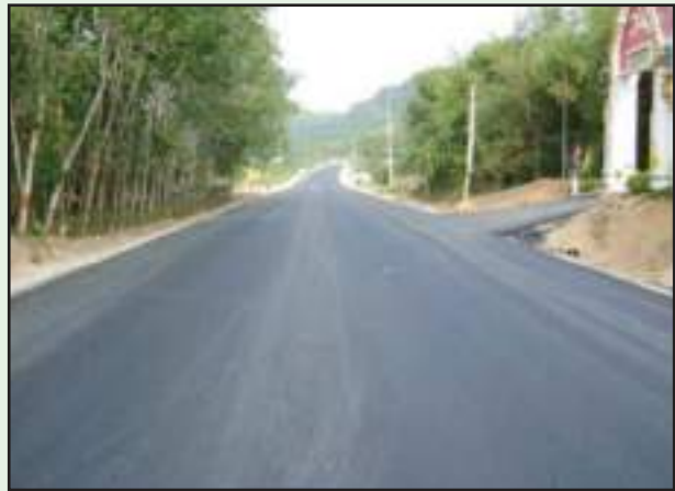
รูปที่ 6-39 ผิวทางที่ก่อสร้างแล้วเสร็จ จะต้องเรียบได้ระดับและรูปแบบ
