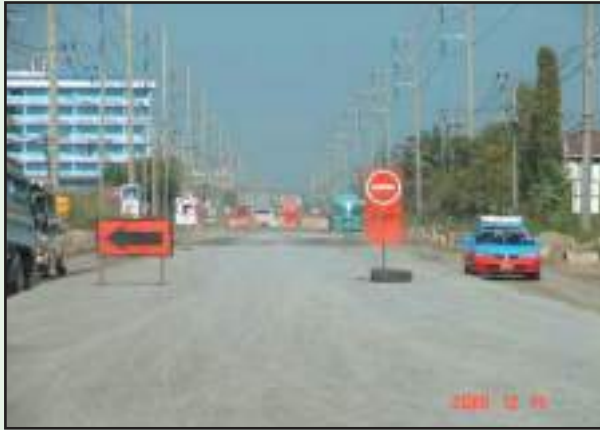
รูปที่ 1 - 4 (ก) การติดตั้งป้ายและสัญญาณควบคุม
