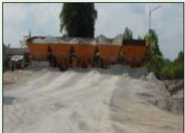
รูปที่ 6-13 ถังหินเย็น
