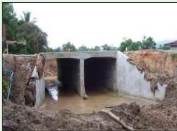
รูปที่ 5-31 บ่มคอนกรีตด้วยกระสอบป่านชุ่มน้ำ
