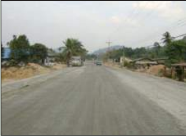
รูปที่ 4-50 ชั้นพื้นทางที่ก่อสร้างแล้วเสร็จ และยังไม่พร้อมโคตต้องฉีดพ่นน้ำหล่อเลี้ยงผิวหน้าเพื่อรักษาความชื้น
