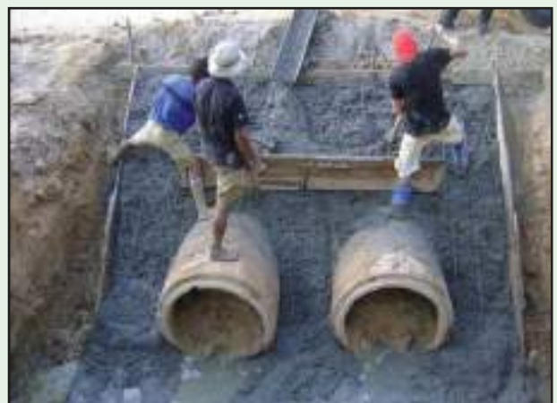
รูปที่ 5-38 การเสริมเหล็ก และการเทคอนกรีตกำแพงปากท่อ
