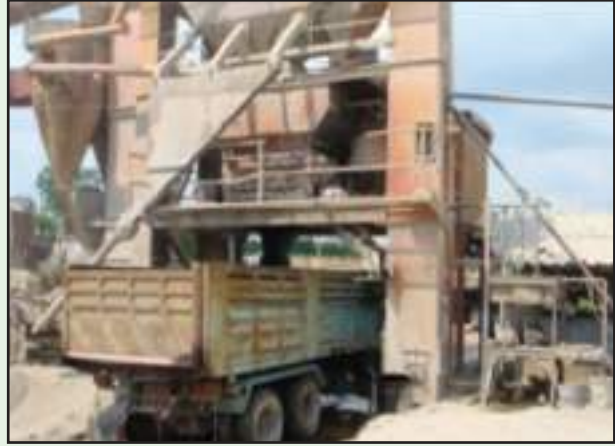
รูปที่ 6-15 ส่วนผสมแอสฟัลต์คอนกรีตถ่ายลงรถบรรทุกเพื่อขนส่งไปยังจุดก่อสร้าง
