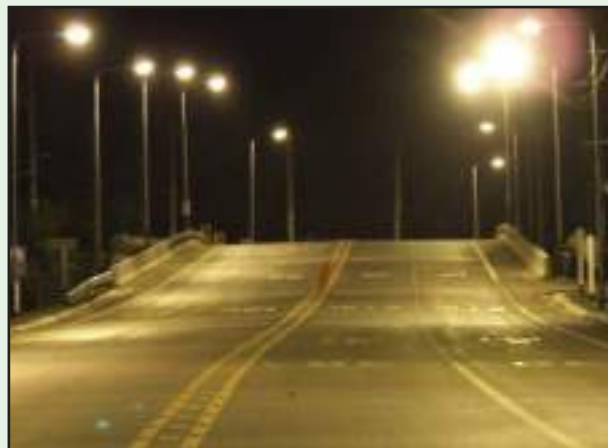
รูปที่ 8-9 การดำเนินงานการติดตั้งระบบไฟฟ้าแสงสว่าง
