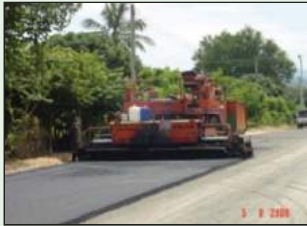
รูปที่ 6-20 เครื่องปูแอสฟัลต์คอนกรีต
