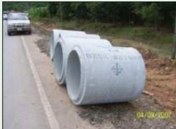
รูปที่ 5-3 ลักษณะท่อที่ดี ผิวเรียบ ไม่มีรูพรุน ปากไม่บิ่น ไม่มีรอยแตกร้าว
