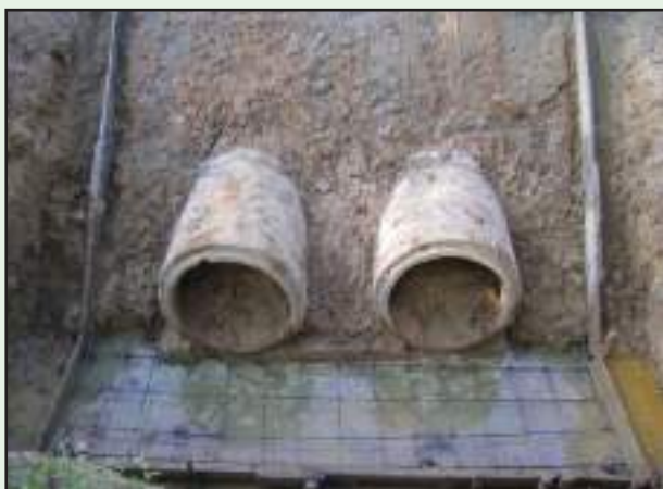
รูปที่ 5-38 การเสริมเหล็ก และการเทคอนกรีตกำแพงปากท่อ
