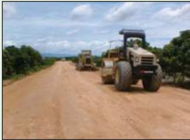
รูปที่ 4-33 การบดอัดใหม่ (Recompaction) เพื่อให้ได้ความแน่นตามเกณฑ์มาตรฐาน
