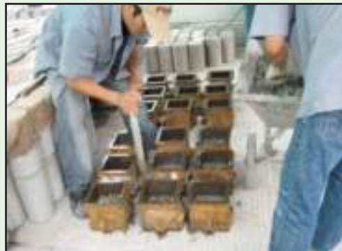
รูปที่ 3-18 การเก็บตัวอย่างคอนกรีตเพื่อทดสอบหาค่ากำลังอัดประลัย
