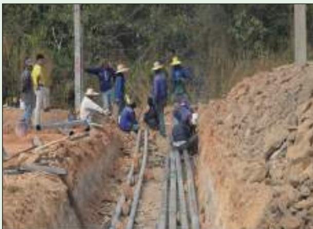
รูปที่ 2 - 1 การขุดหรือย้ายสาธารณสุขปโภค
