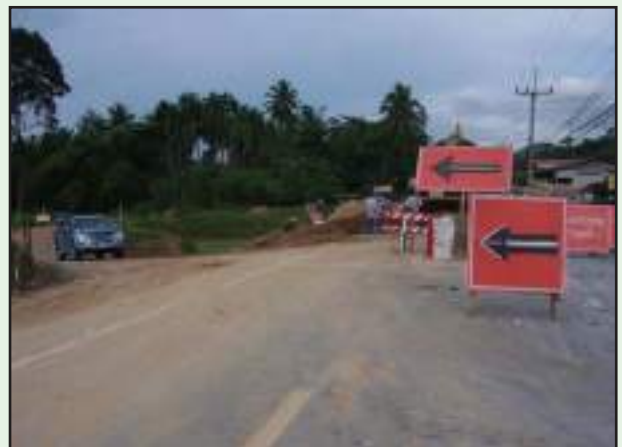
รูปที่ 5-19 แสดงการติดตั้งป้ายเตือนและไฟฟ้แสงสว่างที่บริเวณก่อสร้าง
