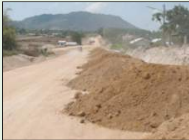
รูปที่ 4-37 กองวัสดุรองพื้นทางบนคันทางหรือชั้นวัสดุคัดเลือก
