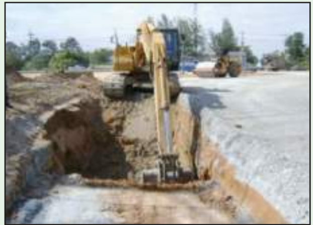
รูปที่ 4-48 การแก้ไขบริเวณชั้นพื้นทางที่เกิดการบวมตัว (Soft Spot)
