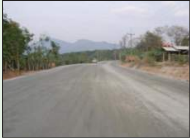
รูปที่ 4-50 ชั้นพื้นทางที่ก่อสร้างแล้วเสร็จ และยังไม่พร้อมโคตต้องฉีดพ่นน้ำหล่อเลี้ยงผิวหน้าเพื่อรักษาความชื้น
