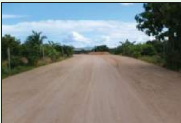
รูปที่ 4-24 งานชั้นดินถมคันทางที่ดำเนินการแล้ว เสร็จพร้อมที่จะก่อสร้างชั้นต่อไป
