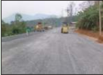
การบดอัดพื้นทาง ด้วยรถบดล้อเหล็ก
