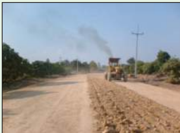
รูปที่ 4-34 การชดเชยวัสดุ (Scarify) เพื่อทำการบดอัดใหม่ในกรณีความแน่นไม่ผ่านเกณฑ์
