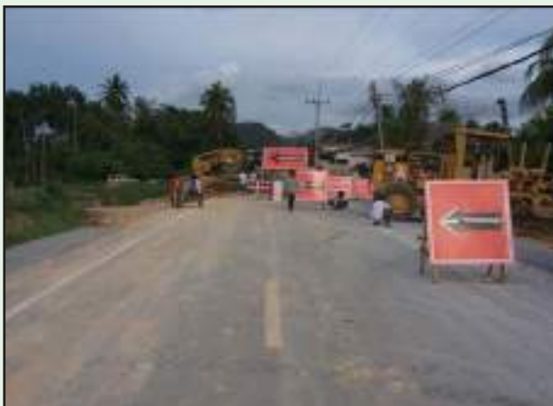
รูปที่ 5-19 แสดงการติดตั้งป้ายเตือนและไฟฟ้แสงสว่างที่บริเวณก่อสร้าง
