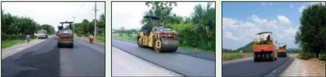
รูปที่ 6-36 การบดทับเริ่มจากบดรอยต่อก่อนและการบดทับด้วยรถบดล้อยาง
