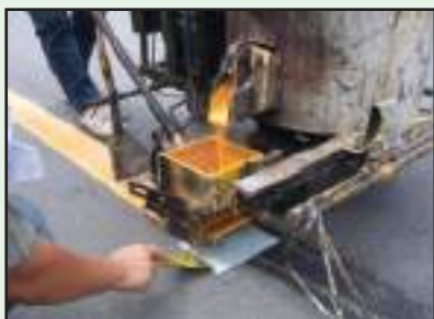
กดแผ่นเหล็กให้อยู่กับที่ขณะทาสี
