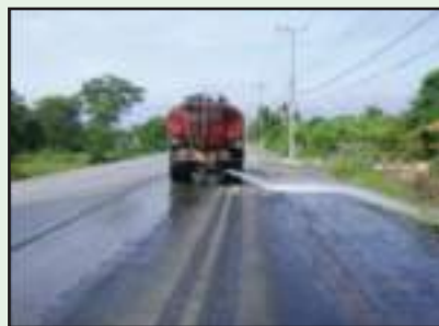
รูปที่ 6-25 ฉีดล้างทำความสะอาด ก่อนปูแอสฟัลต์
