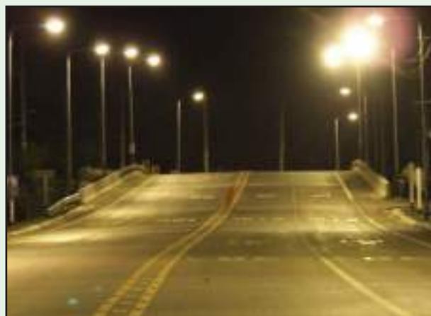
รูปที่ 8-9 การดำเนินการติดตั้งระบบไฟฟ้าแสงสว่าง
