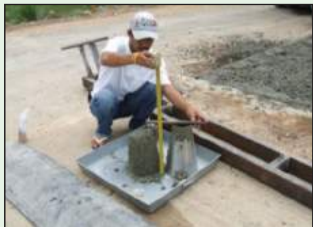
รูปที่ 6-56 ตรวจสอบความชื้นเหลวทันทีที่รถลำเลียงมาถึง
