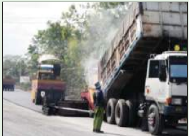
รูปที่ 6-27 รถบรรทุกส่วนผสมแอสฟัลต์คอนกรีต (Hot Mix) ต้องคลุมผ้าใบตลอดเวลา
