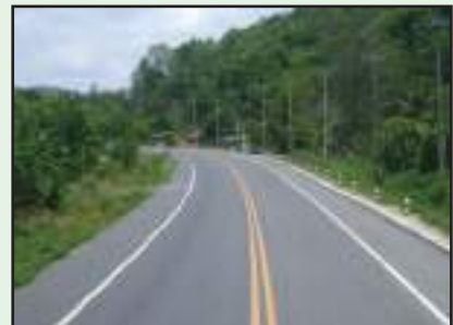
รูปที่ 7-14 สีที่ทาลงบนผิวจราจรจะต้องคงอยู่ และสะท้อนแสงได้ดีภายใต้สภาพการจราจรปกติ ไม่น้อยกว่า 24 เดือน
